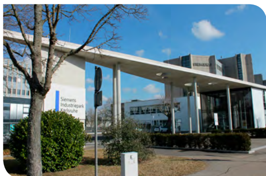
Siemens Industriepark Karlsruhe
